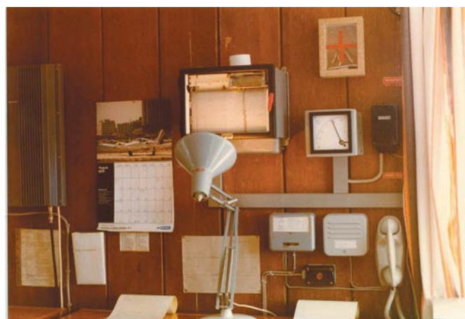
Vindskriver, visning af udendørstemperatur, alarmtelefon, sirentryk m.v.
