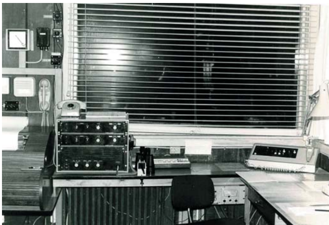
„Tårnet“ (nuværende Blue Ice Cafè) i slutningen af 70'erne. Flyradio t.h. og reserve radio t.v. samt InterCom til Brand- og redning samt tankmand. Øverst t.v. visning af udendørs temperatur
